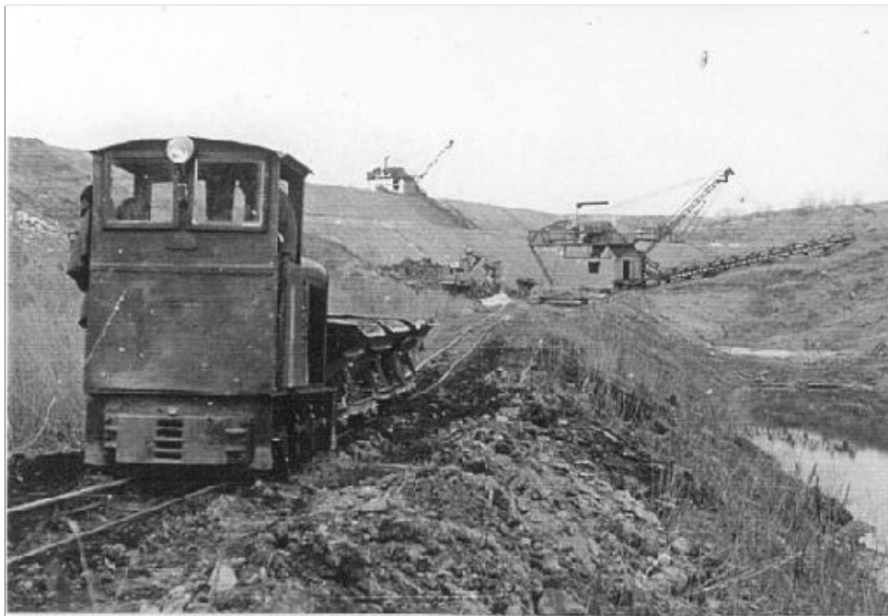
Abb. 2 Baggeranlage Malliß 1979 Foto: W. Krempien, Schwerin
