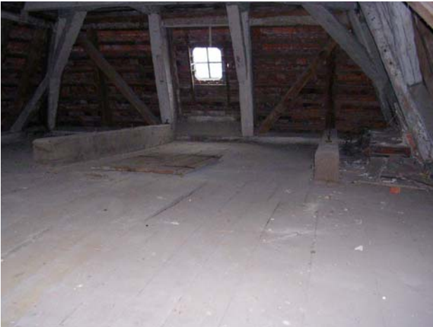
Abb. 7: Lagerbalken (Überzüge) im Dachgeschoss, 2005
