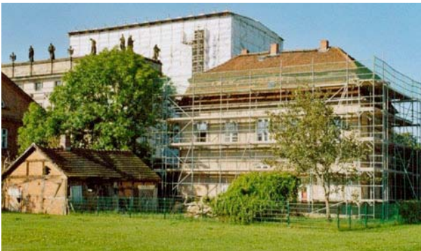
Abb. 1: eingerüstetes Fontänenhaus, September 2004
