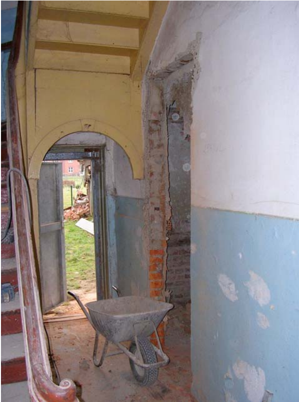
Abb.2: neuer Wanddurchbruch zum geplanten Zoologieraum
