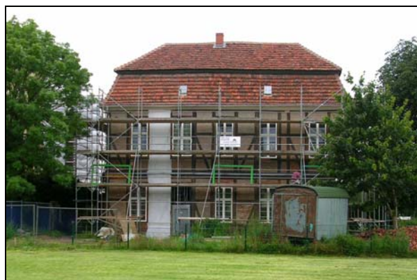
Abb. 23: Probeanstrich für die Fassade im August 2005
