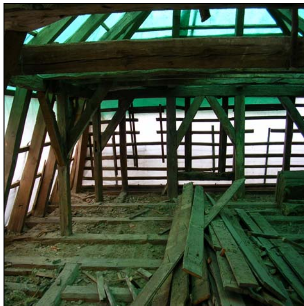
Abb. 13: Dachgeschoss bei der Sanierung
