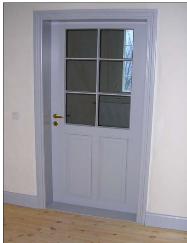
Abb. 20: Restaurierte Tür im Obergeschoss
