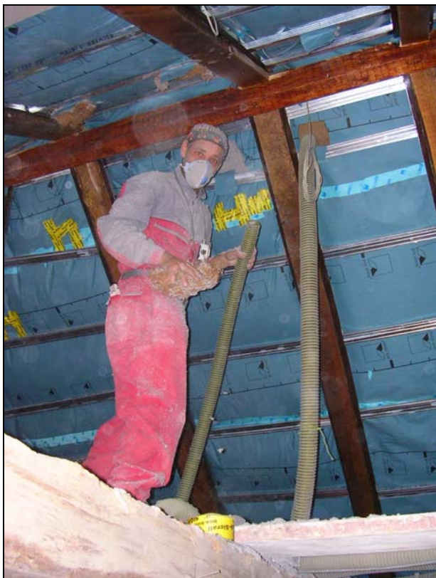
Abb. 21: Einbringen der Isolierung im Seminarraum im August 2005
