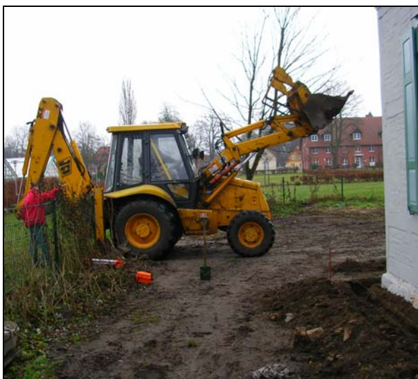
Abb. 25: Beginn mit den Arbeiten zur Pflasterung
