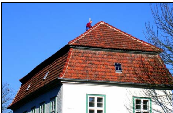
Abb. 12: neu gedecktes Walmdach
