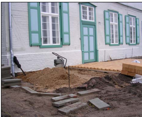
Abb. 26: Fast fertige Pflasterung am hinteren Eingang im Dezember 2005
