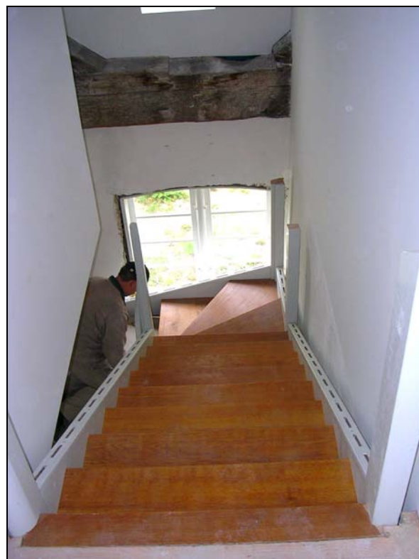
Abb. 18: Einbau der neuen Treppe im September 2005
