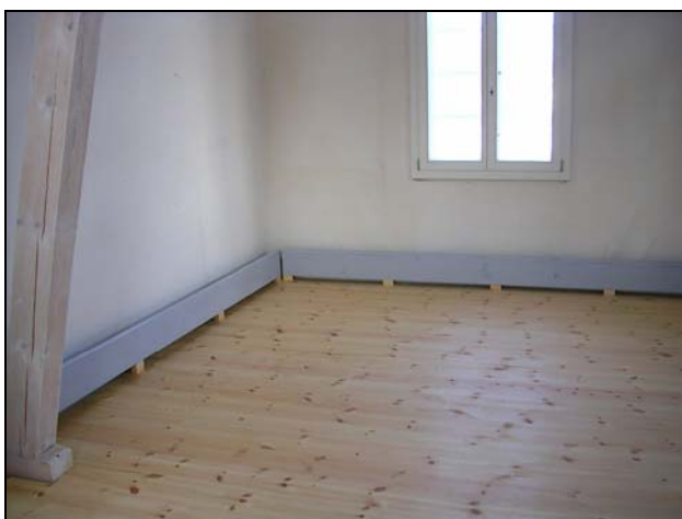
Abb. 22: neue Fußbodendielung mit Verkleidung der Lamellenheizkörper
