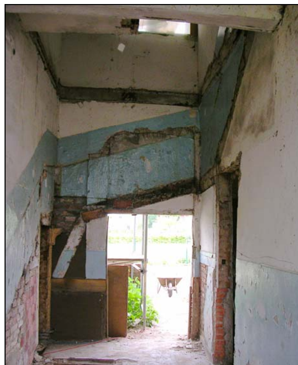
Abb. 17: Demontierte Treppe im Juni 2005
