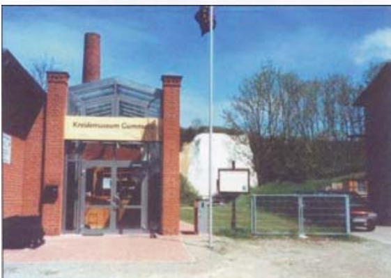
Abb. 9: Eingang zum Kreidemuseum im ehemaligen Maschinenhaus in Gummanz auf Rügen
