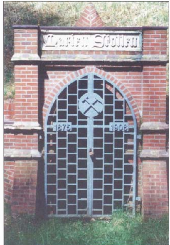
Abb. 12: Rekonstruiertes Mundloch des Marienstollens bei Malliß (Braunkohlentiefbau).
