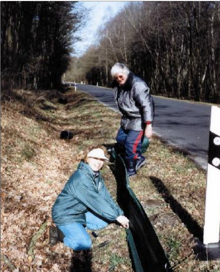
Abb. 1: Aufbau des Schutzzaunes
