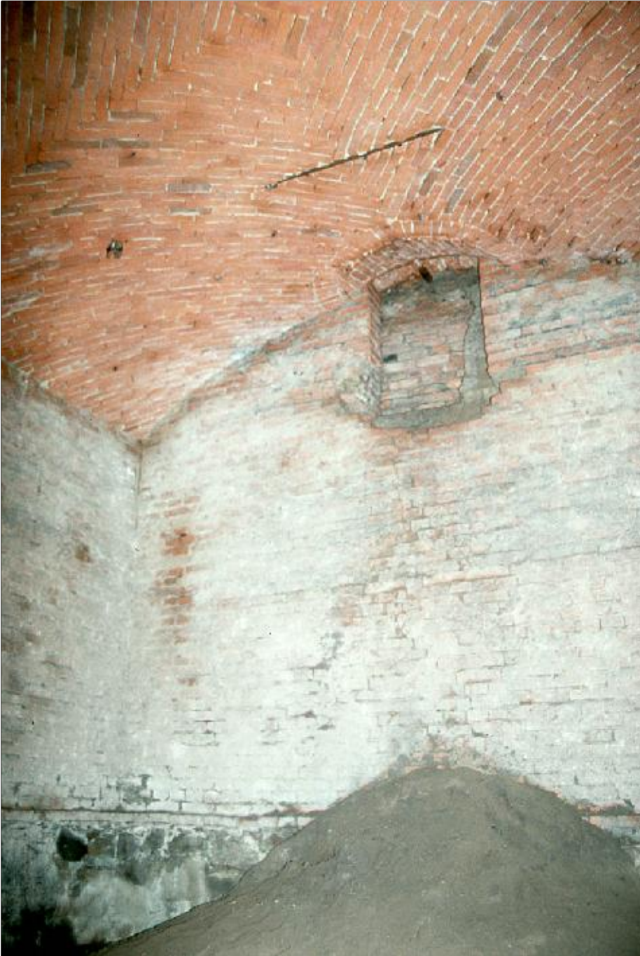
Foto 4: Raum 4 mit Kuppelgewölbe
