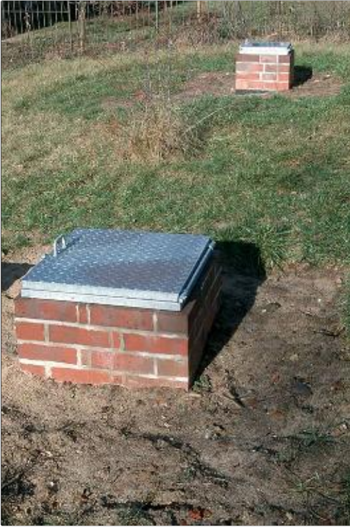
Fotos 1 und 2: Eingang des Eiskellers und Lüftungsschächte
